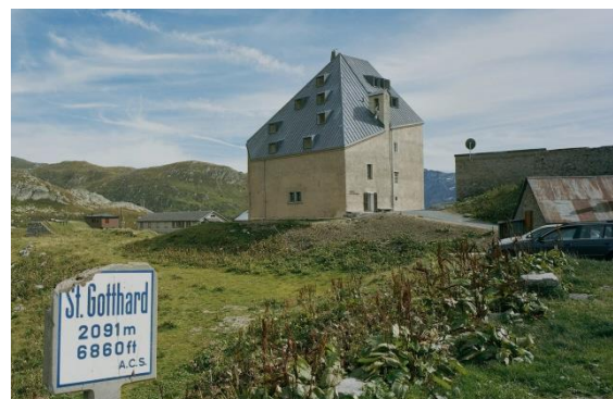
St. Gotthard Hospiz, 2010 (nach Sanierung), © Ruedi Walti, Basel
