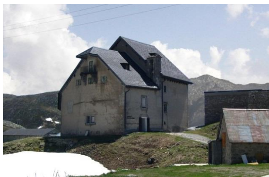
Hospice du Gothard 2005, avant la rénovation © Miller & Maranta, Bâle
