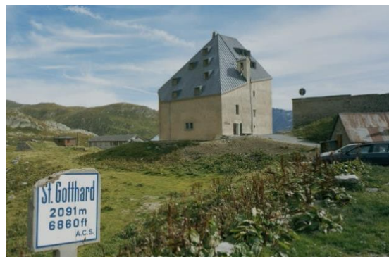
Hospice du Gothard 2010, après la rénovation © Ruedi Walti, Bâle
